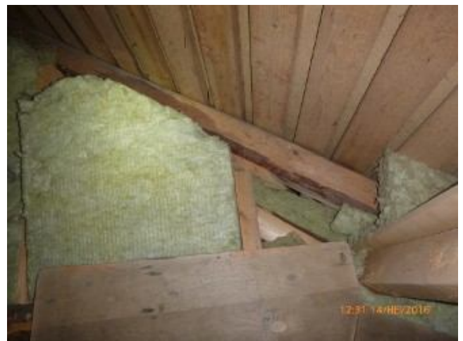
Vinon lämmöneristetyn katon suuntaisen osan tuuletuksen toimivuutta ei saatu selville
