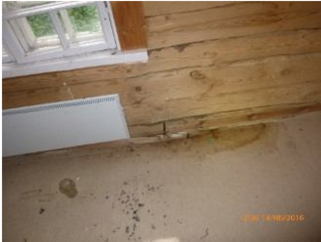
Alakerran lattiassa vesivuodon aiheuttama vaurio samassa kohdassa jossa kattoikkuna vuotaa
