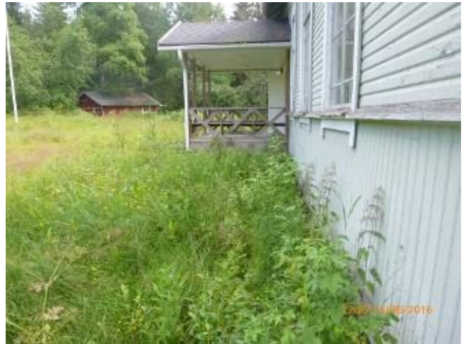
Maanpinta kaataa etupihalla rakennukseen päin
