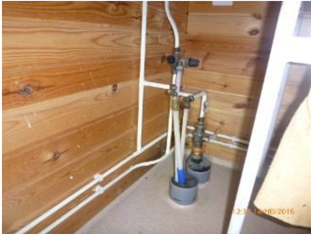
Putkiläpiviennit epätiivit rossipohjaan nähden
