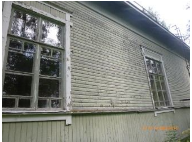
Ulkovuorauksen maalipinta ravistunut
