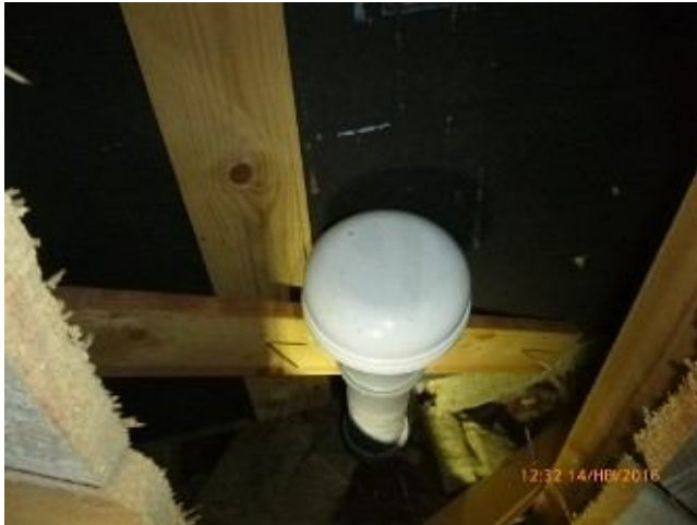
Viemärin tuuletus päättyy alipaineventtiilillä yläpohjaan
