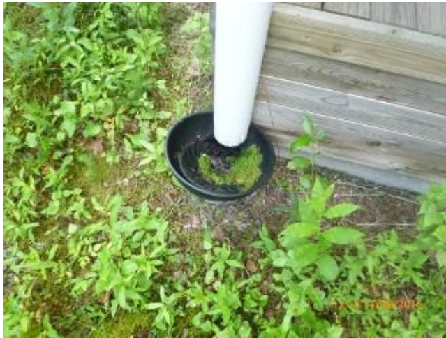
Kattosadevedet ohjautuvat sadevesikaivoon
