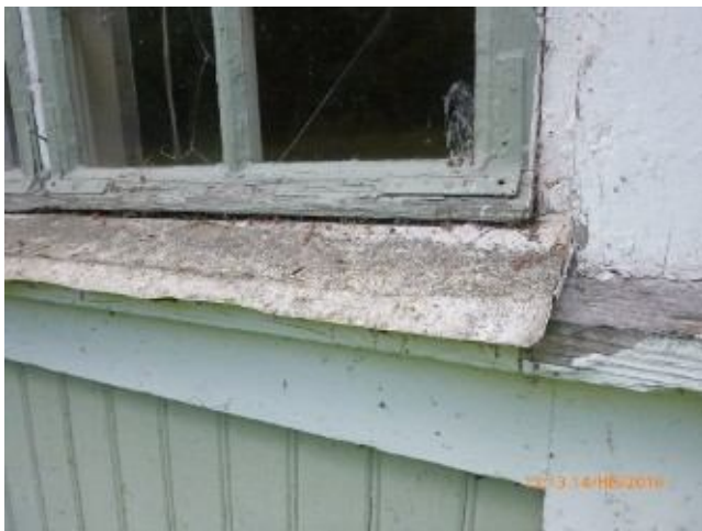
Ikkunat huonossa kunnossa
