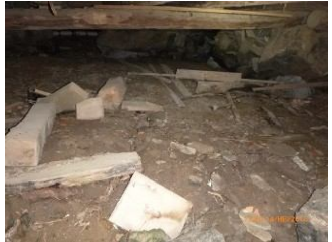
Ryömintätilassa hajoavaa puujätettä yms. eloperäistä ainesta
