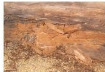
Kondenssia tapahtuu myös uusissa hirsirakennuksissa, jos seinän ja yläpohjan liitoksessa on ilmavuoto. ( konvektiovirtaus )
