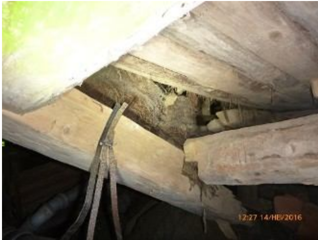
Lattiarakenne antanut periksi
